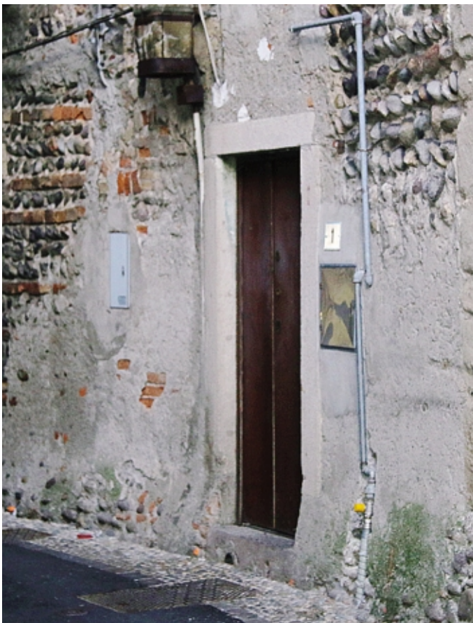
L'ingresso dell'abitazione in vicolo Caio dove è scoppiato il rogo
