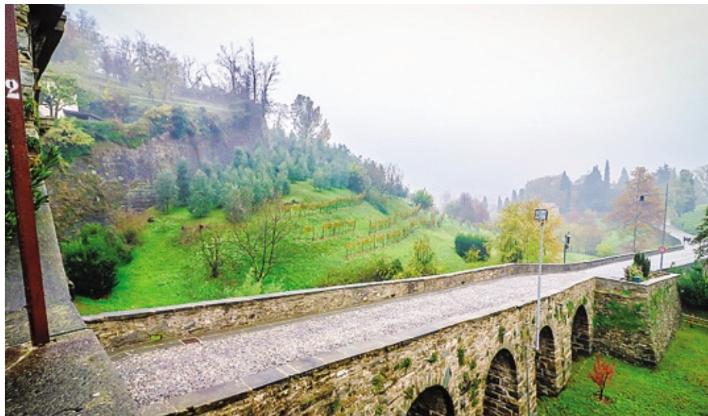
Il viadotto che conduce a Porta Garibaldi e il versante settentrionale delle Mura
