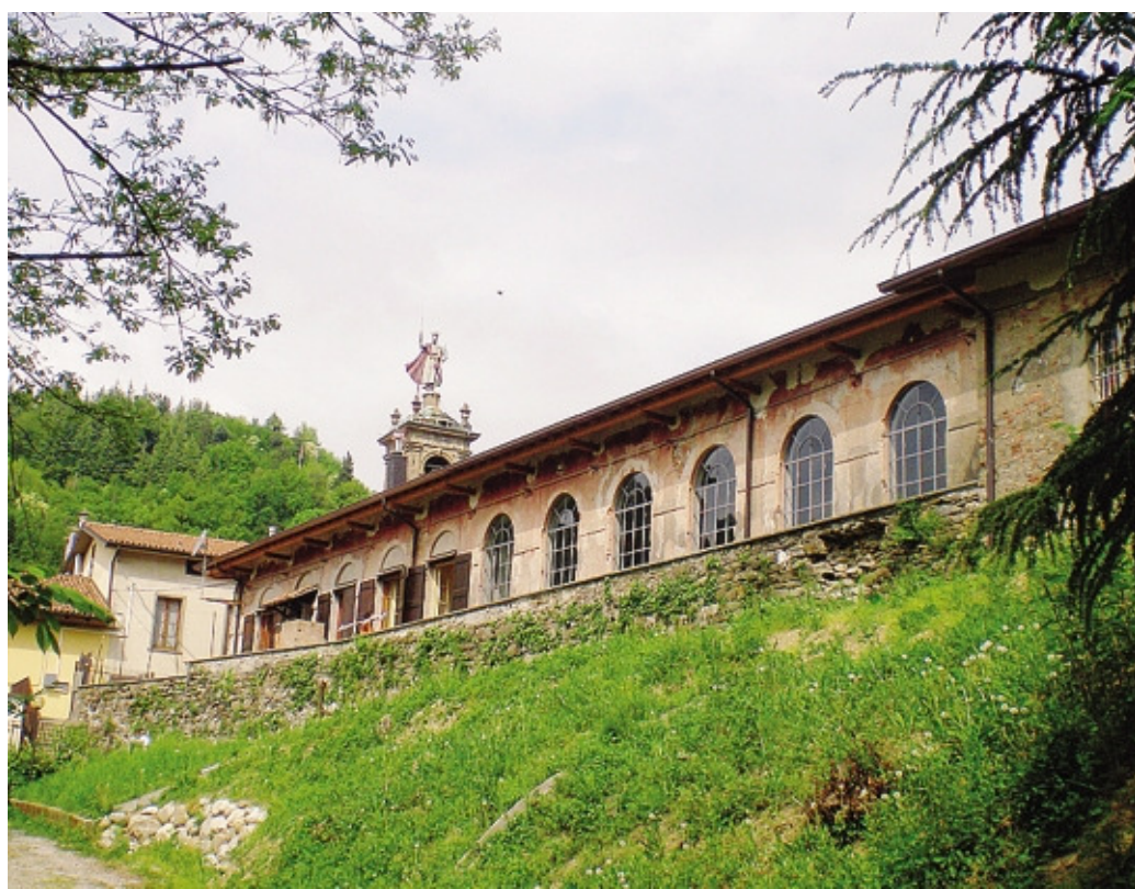
L'edificio che ospitava la filanda, proprio accanto all'abbazia di Pontida
